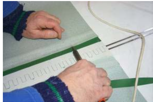
Dünnes PVC- o. PU-Band einlegen und mit LötKolben o. Leister anheften, um den Abstand zu füllen
